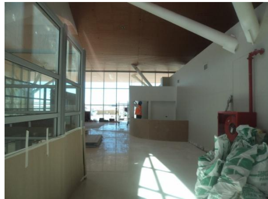
(4) Salón VIP (Trabajos de Instalación)
